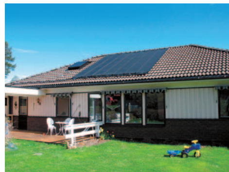
15m 2 of solar collectors for in-ground family pool. Installation av 15 m 2 solfångare för familjepool.
